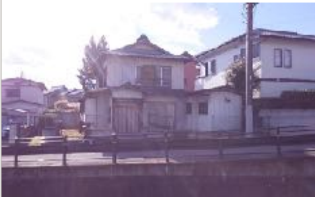
渋川市補助金を使った 解体工事
