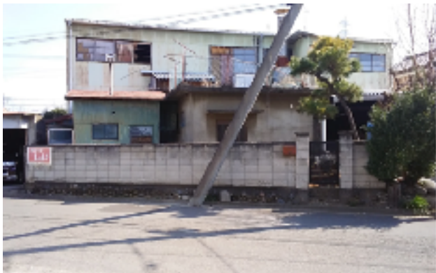
朝倉町解体工事 施工前
