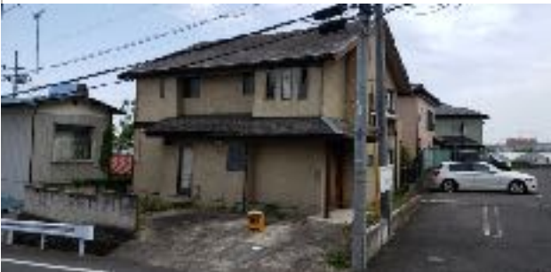
駒形町一般住宅 解体工事
