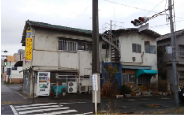
前橋市本町住宅付き店舗 施工前
