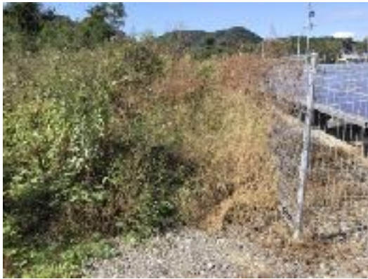
太陽光発電所 施工前
