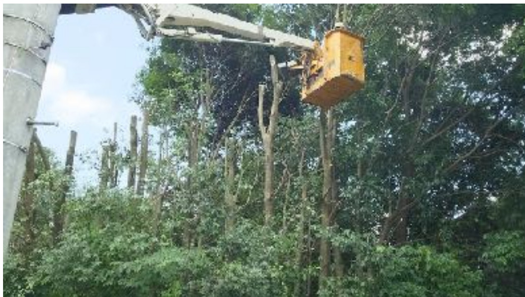
高所作業車による枝切り作業
